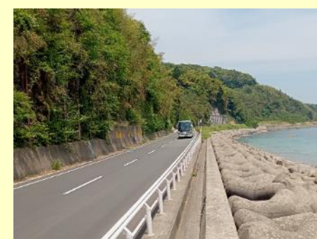
国道178号 (里波見～長江(宮津市))
