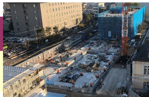
(工事の状況(令和4年1月現在))
