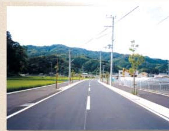
主要地方道の改良整備
