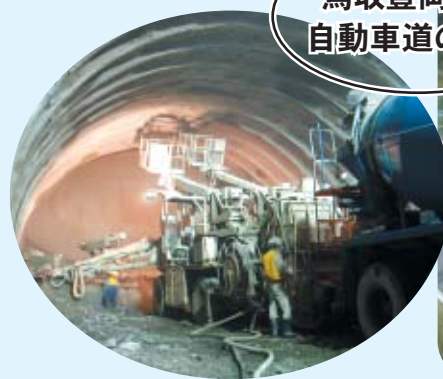
第12トンネル(仮称)本抗掘削現場
