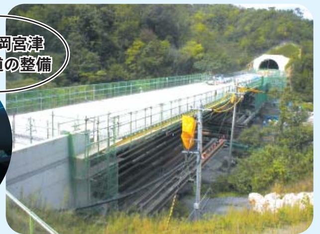
宮津7号橋(仮称)と第13トンネル(仮称)抗口
