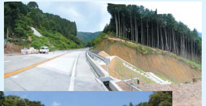
▼国道176号(与謝峠)の復旧状況
