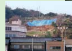
▽間人地区土砂崩壊箇所 (11月現在)
