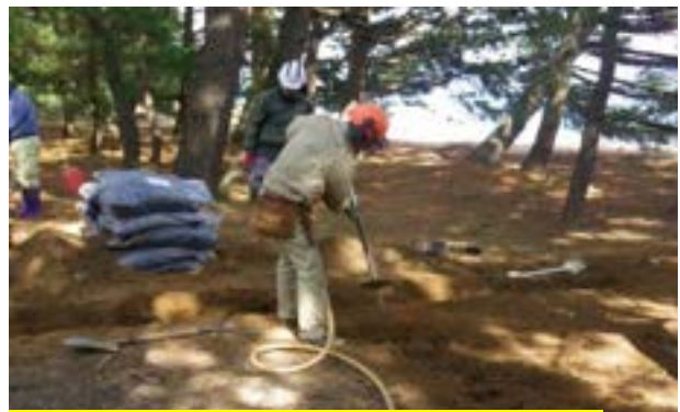
②トレンチの掘削 エアースコップ使用
