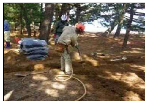
《エアスコップによる表層土壌の剥ぎ取り》 【施工方法1の例】
