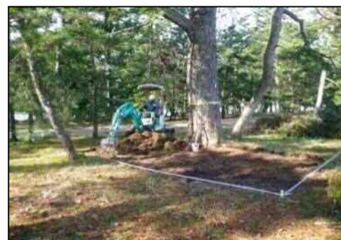
《重機による表層土壌の剥ぎ取り》 【施工方法2の例】
