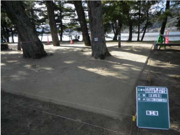
最後に遅効性化成肥料を撒き、海砂を約10cm敷き詰めて完了。
