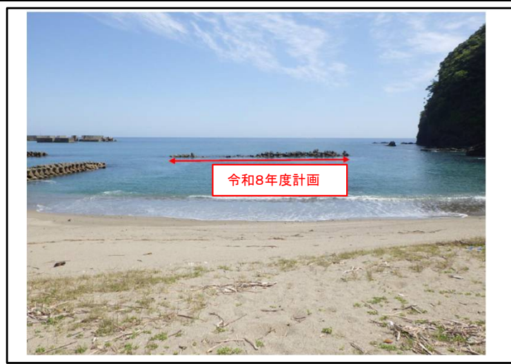
海岸保全施設 離岸堤
