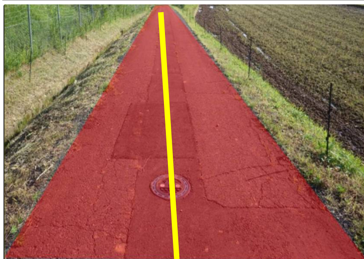
送水管本復旧
