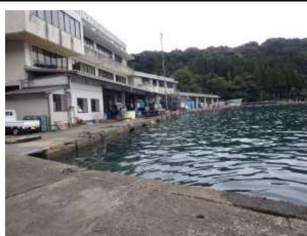
大浦第1岸壁 全景
