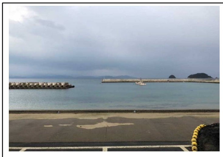
防砂突堤整備
