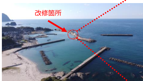
老朽化した防波堤の改修を行った中浜漁港
