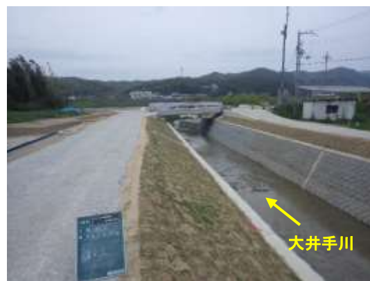
整備後 (木津川合流点上流)
