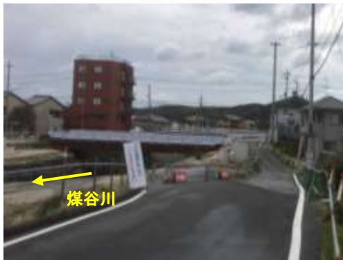
整備前 (茶屋前橋付近)
