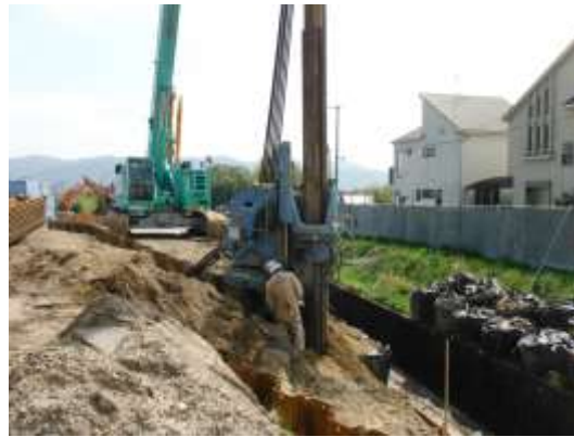
図- 344 近接家屋への騒音・振動対策の実施 (パイルオガー併用圧入工法) (防賀川)
