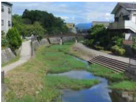
大谷川（安居橋周辺）
