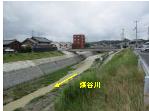
整備後 (茶屋前橋付近)
