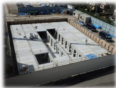
⑦ 平成29年10月4日(東面より望む)
