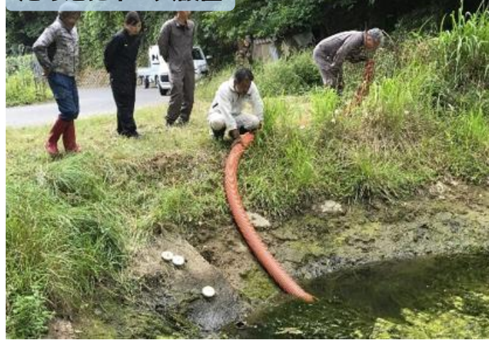
ため池にホース設置
