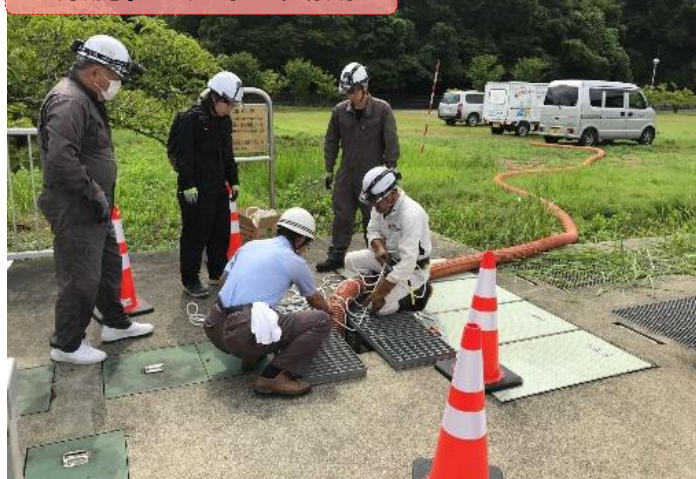
塩素混和池にホース設置
