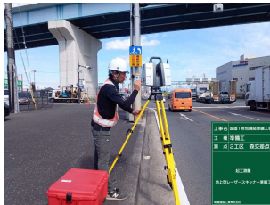
地上レーザースキャナによる測量
