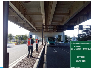
ドローンが飛ばせない工区は360°カメラで撮影
