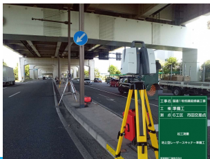
地上レーザースキャナによる測量
