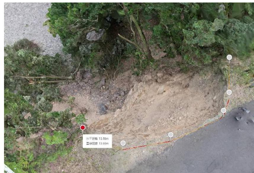
法面崩土の仮囲いの概算数量を測定
