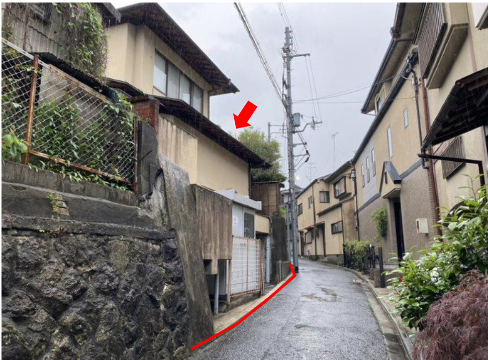
南東側より撮影
