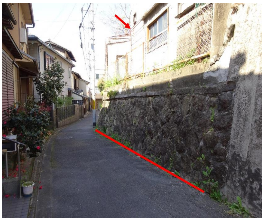
南東側より撮影
