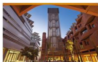
上空の風を冷気に変えて地面に吹き付ける仕組み(大和ハウス工業ホームページより引用)
