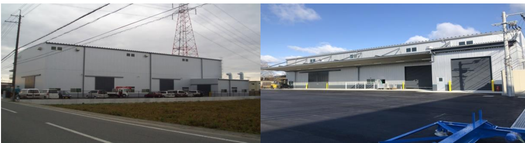
(左から、③製缶工場、④装置組立工場)
