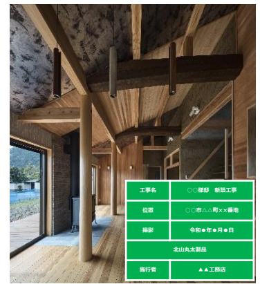
北山丸太製品施工状況の写真
