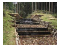
木製治山ダム
