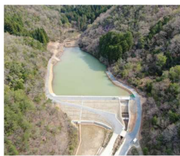
改修済みため池
