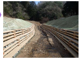
危険木撤去状況
