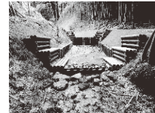
木製流路工による流出土砂対策
