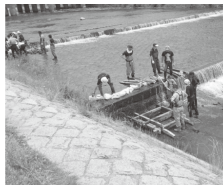
鴨川での魚道設置作業（三条大橋付近） （令和2年6月）
