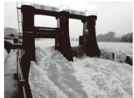
改修前（洪水時ゲートが一つ上がらない）
