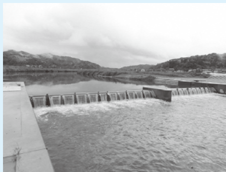
せき上げた鋼製ゲート（令和元年5月）
