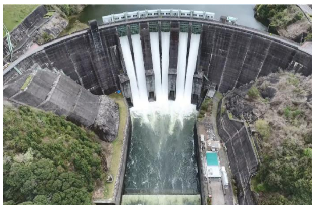
令和6年高山ダムからのフラッシュ放流状況
