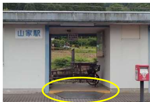
【山家駅の段差へのスロープ設置】
