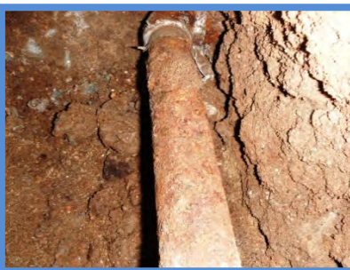
○埋設年数 : 48年 ○建物 : 雑居ビル ○所在地 : 広島県呉市
