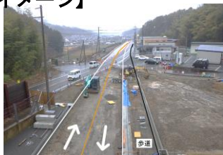
【①トンネル西側暫定車線】
