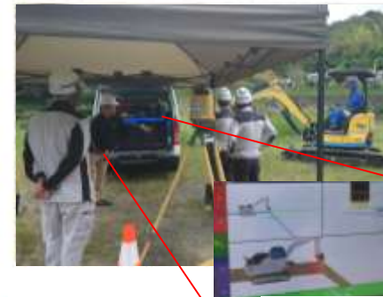
マシンガイダンス表示画面 (掘削の位置・深さを表示)
