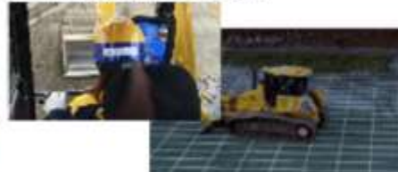
ICT建機による施工
