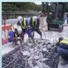
▲修繕・耐震補強
