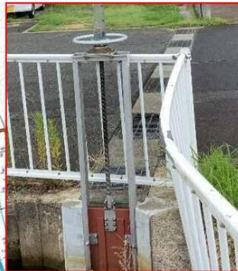
図-1 逆流防止ゲート整備 (イメージ図)
