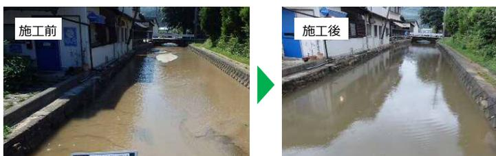
図-1 河道掘削施工イメージ
