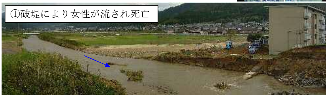
図 5 浸水被害状況（平成 16 年 10 月台風 23 号）
