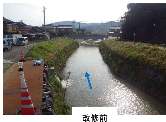
図7 加悦奥川の改修状況
