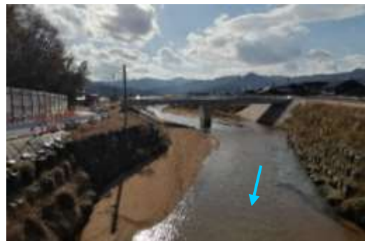
改修中の島大橋 (下流から島大橋の方向)
