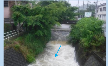
旧支所下流側農業取水用固定堰
