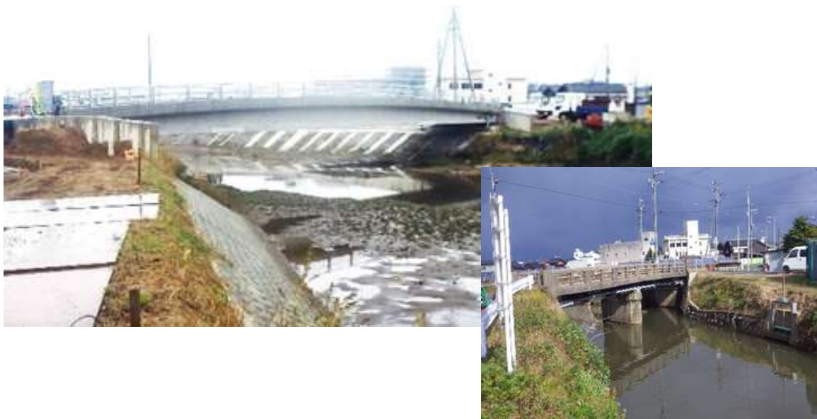
図 8 福田川の改修状況
