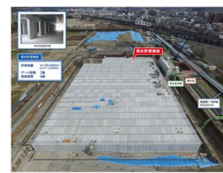
雨水貯留施設(安満遺跡公園)
