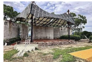
野外ステージ改修
