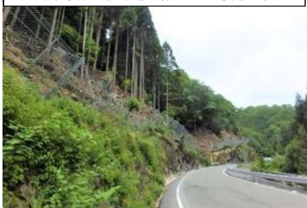
法面对策事業 (枚方亀岡線) R6 工事完了予定
