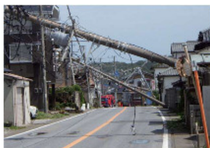
【写真-6 他府県の電柱倒壊事例 (国交省 HP から引用)】
