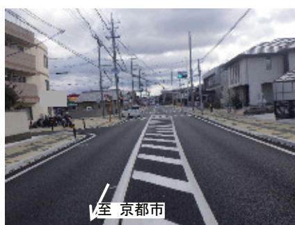
【写真-1 整備済み区間】
