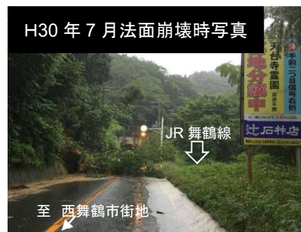
写真-4 土砂災害の状況
