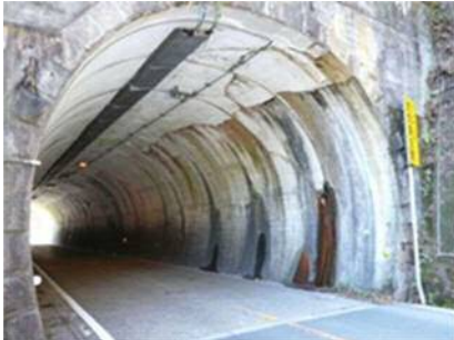
写真-A トンネルの状況
