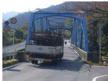
写真-E 音海橋の通行状況
