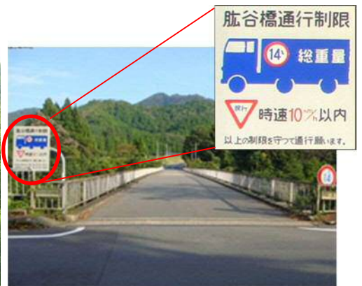
写真-L 肱谷橋通行制限
