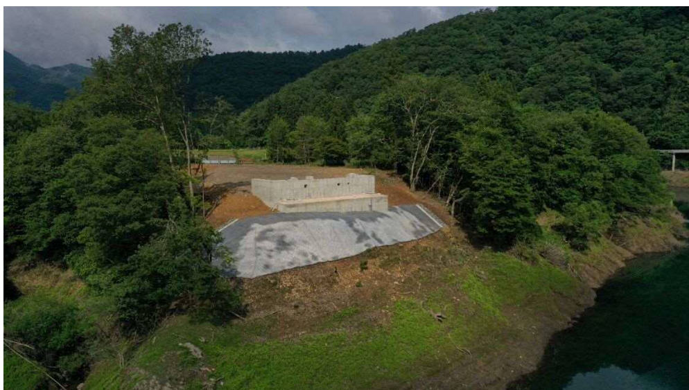
写真-M 新肱谷橋(仮称) A1 橋台の完成写真
