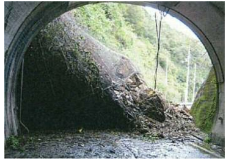
写真-G トンネル付近の土砂災害発生状況
