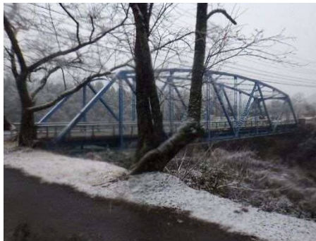
写真-H 音海橋の状況
