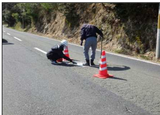
日常点検（道路パトロール）
