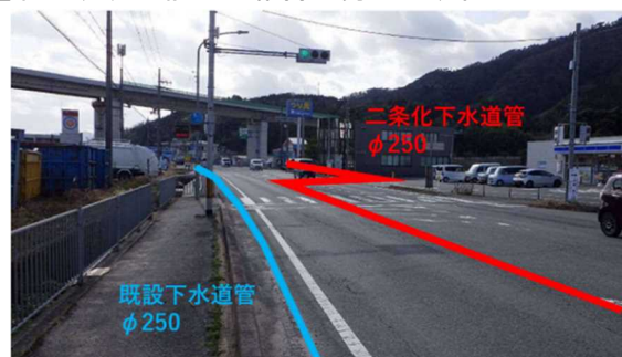
二条管増設箇所
