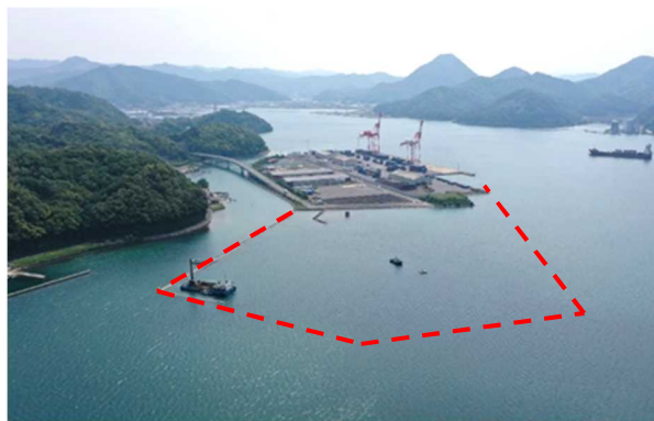
舞鶴国際ふ頭Ⅱ期整備
