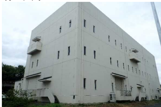
水処理電気棟（耐震補強）
