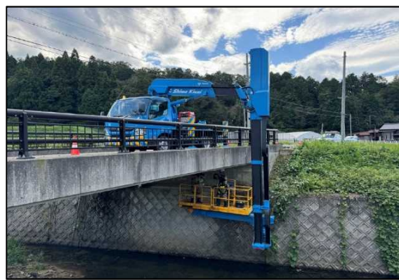
定期点検（橋梁点検）
