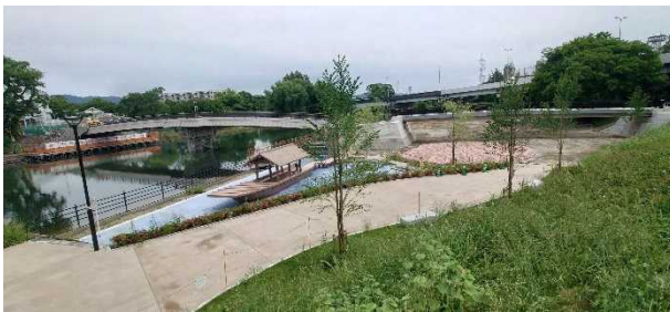
伏見みなと公園広場（完成部分）
