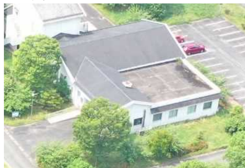
第1ポンプ棟(耐震補強)
