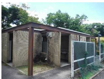
山城総合運動公園 屋外トイレ
