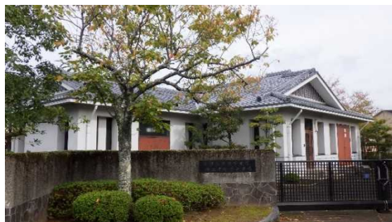
中継ポンプ場（耐震補強）
