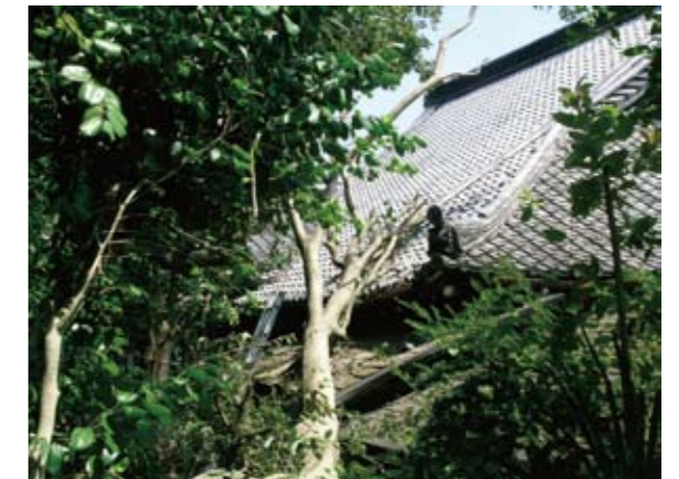
萬壽院(宇治市) 府指定有形文化財・客殿 突風で倒れた大木による屋根破損の修理
