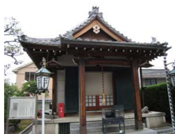
念仏寺(城陽市) 境内の防火対策 (自動火災報知器設置等)
