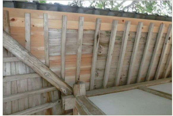
〈修理後の軒廻〉
