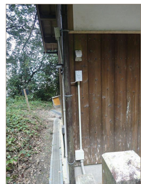
〈設置後の防犯カメラ：右、電気設備：左〉
