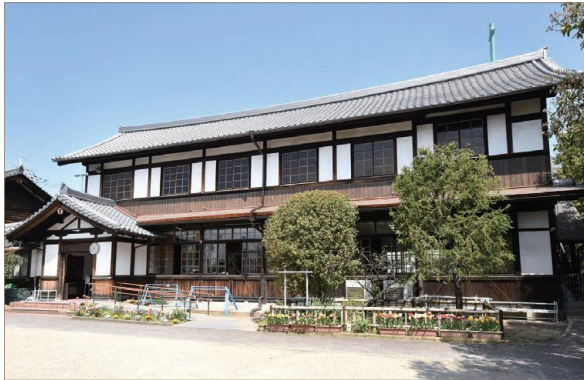
〈礼拝堂外観：修理後〉
