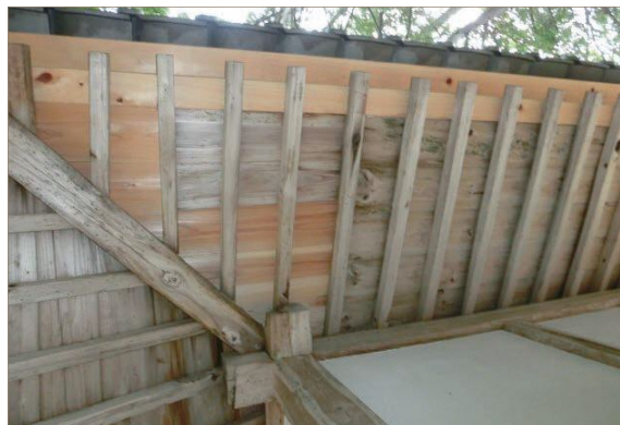
〈修理後の軒廻〉
