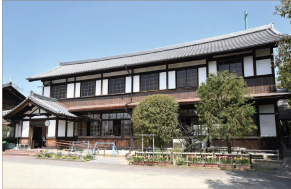
〈礼拝堂外観：修理後〉
