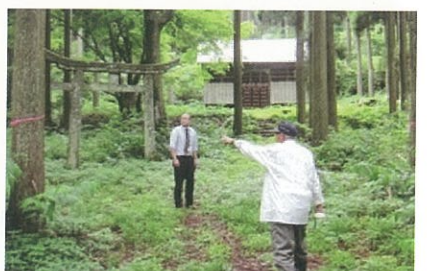
写真⑨ 寺領観音堂(伊根町) (未指定文化財・保存修理)
