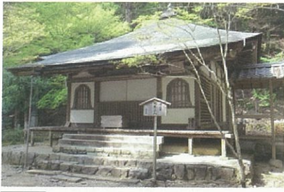
写真① 高山寺・開山堂(右京区) (未指定文化財・屋根修理)
