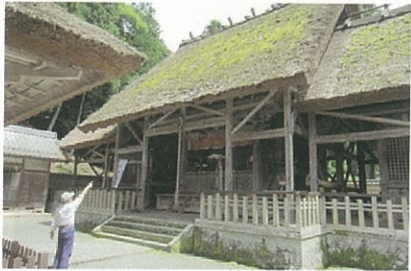
写真⑤ 摩氣神社・本殿覆屋(南丹市) (府指定文化財・屋根修理)
