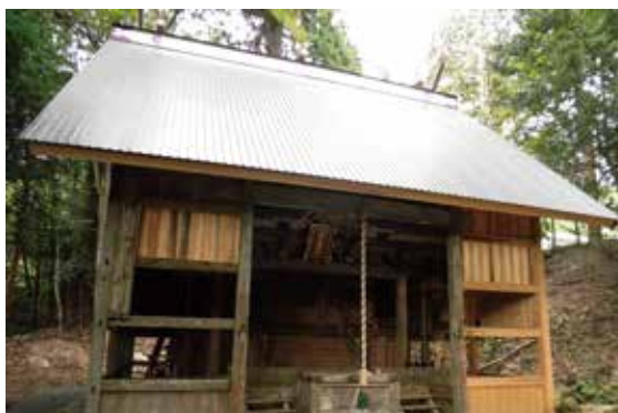
修理後の本殿及び覆屋
